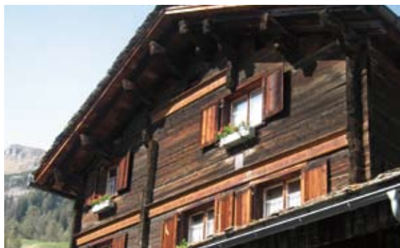
Ein großer Dachüberstand schützt Hauswand, Fenster und Türen vor der Bewitterung.
