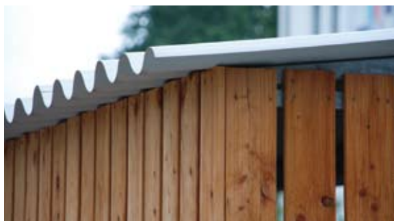
Dachüberstand bei einer Müllboxenverkleidung schützt das Holz vor direkter Bewitterung
