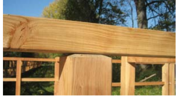
Dieses Geländer aus Lärchenholz wurde völlig ohne Oberflächenbehandlung im Freien eingebaut
