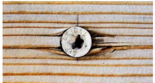
Korrosionsbeständige Schrauben sind für harzhaltiges Lärchenholz geeignet.
