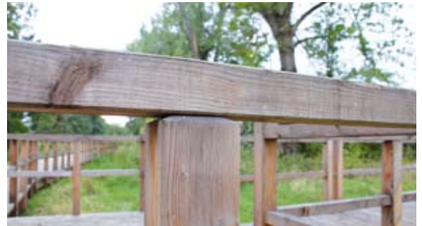
Nach einem Jahr bei Wind und Wetter hat die Holzoberfläche der Balkenverbindung die typische silbergraue Patina angenommen.
