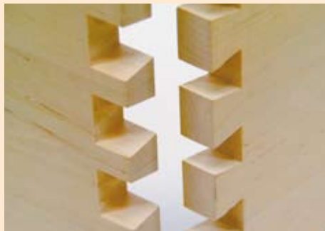
Offene Schwalbenschwanzverbindung
