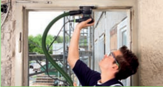
Der RTS 400 ist die erste Wahl, wenn es um den Anschliff schmaler Flächen geht – von Türrahmen und -falzen im Außenbereich ...
