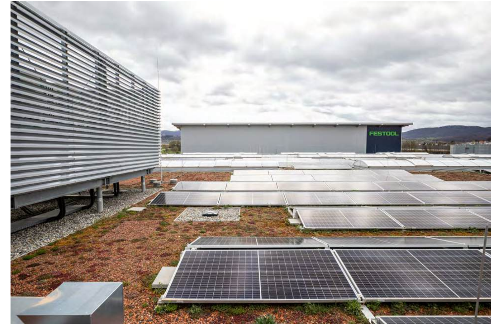
Die Photovoltaikanlage auf dem Dach der Montagehalle in Weilheim mit einer Kapazität von 600 kWp versorgt, bilanziell betrachtet, den gesamten Produktionsstandort Weilheim mit eigenem Strom.
